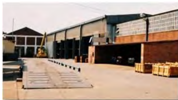
Vista exterior da fábrica e da ponte-báscula
